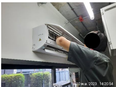
รูปที่ 2-26 ล้างเครื่องปรับอากาศและล้างฟิลเตอร์พื้นที่ส่วนกลาง
