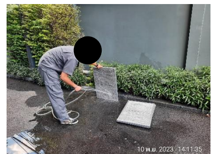
รูปที่ 2-26 ล้างเครื่องปรับอากาศและล้างฟิลเตอร์พื้นที่ส่วนกลาง
