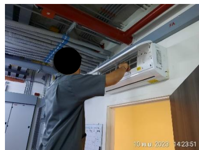
รูปที่ 2-26 ล้างเครื่องปรับอากาศและล้างฟิลเตอร์พื้นที่ส่วนกลาง
