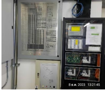
แผงควบคุม (Fire Alarm Control Panel : FCP)
