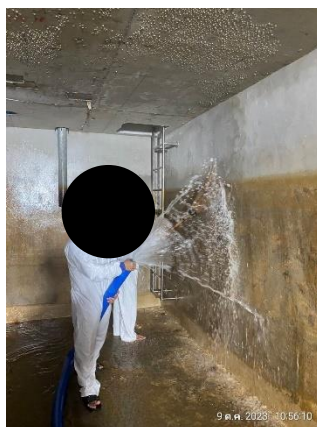
รูปที่ 2-36 เจ้าหน้าที่ล้างถังเก็บน้ำชั้นใต้ดินและชั้นดาดฟ้า เมื่อวันที่ 6,9 ตุลาคม 2566
