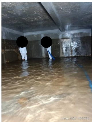
รูปที่ 2-36 เจ้าหน้าที่ล้างถังเก็บน้ำชั้นใต้ดินและชั้นดาดฟ้า เมื่อวันที่ 6,9 ตุลาคม 2566
