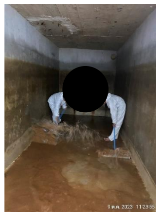
รูปที่ 2-36 เจ้าหน้าที่ล้างถังเก็บน้ำชั้นใต้ดินและชั้นดาดฟ้า เมื่อวันที่ 6,9 ตุลาคม 2566
